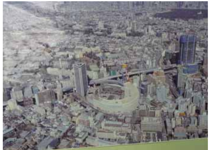
建設中の大橋ジャンクションと再開発ビル
