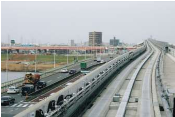
扇大橋付近の軌道
