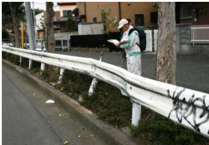
ガードレールの変形を調べる
